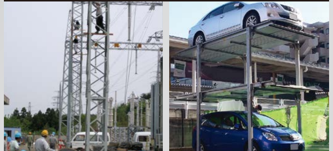
เสาเหล็ก
