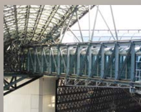
駅ビル渡り廊下
