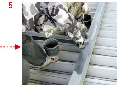
30～60分後、塗装面が乾燥している ことを確認し、2回目の塗装を行う
