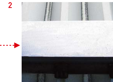
清浄な鉄面を露出させる
