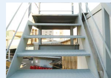
外部鉄骨階段
