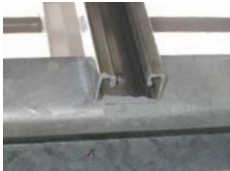
ZAM鋼板の端面補修
