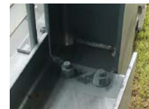
ローバルで補修
