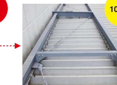
施工から10年後の様子
