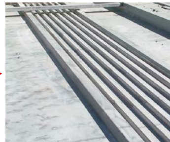
ケレン完了 (オイル付着部は溶剤拭きし、砂や土汚れには高圧水洗浄を推奨)
