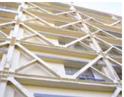
施工例(耐震補強工事)
