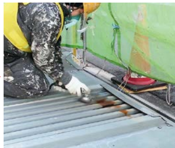
ケレン作業 赤さびは動力工具を用いて除去。白さびは研磨用たわしでこするだけでOK！
