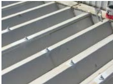
ガルバリウム屋根のネジ部
