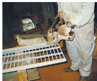
グレーチングを斜めにカット
