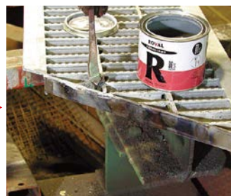
溶接箇所およびフラットバーに ローバルを塗装(2回塗りしてください)
