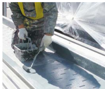
ローバル塗装 鉄・亜鉛めっき面に直接塗装する
