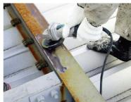
使用喷砂或者电动工具, 完全去除水分, 油污,氧化皮,铁锈,旧涂膜,使之露 出清洁的铁面,镀锌面。
