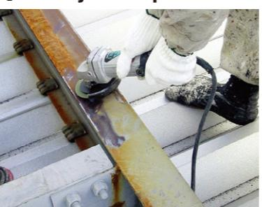
Sediakan permukaan logam dengan cara di blasting atau dengan gerinda. Buang semua pencemaran di permukaan seperti kelembapan, minyak, skala mil, karat, dan cat lama.
