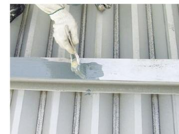
2回塗り80μm(1回40μm×2)塗り延ばさずたっぷりと塗ります。さび止め能力は膜厚に比例します。塗装間隔: 30分~60分
