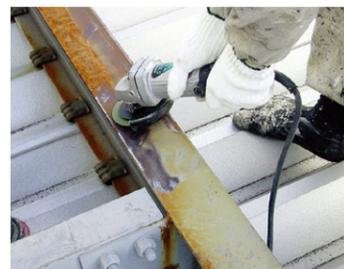
ブラストまたは動力工具を使用して、水分・油分・黒皮・さび・旧塗膜を除去し、清浄な金属面を露出させます。
