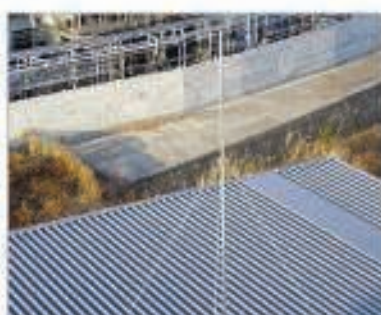
สายล่อฟ้า
