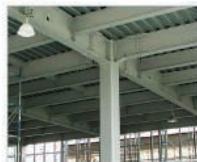
โครงเหล็ก
