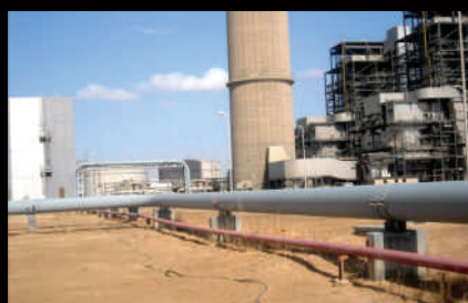
埃及 煤氣管道塗裝
