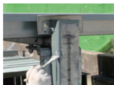
鍍鋅面上直接塗刷
