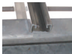
鍍鋅鋁鎂鋼板的切割端面修補
