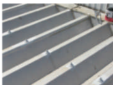
鋼板屋頂的螺栓部分加強
