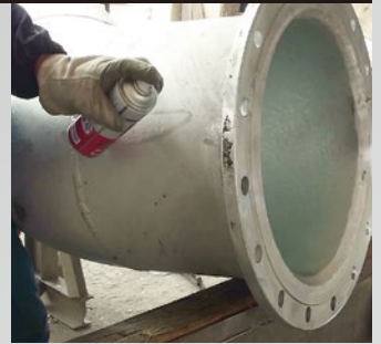
Bagian tidak disalut
