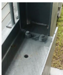
ローバルで補修
