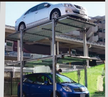
機械式立体駐車場設備
