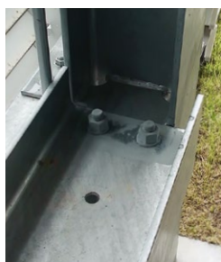
ローバルで補修
