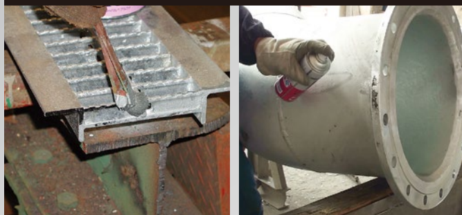
切断面、溶接部
