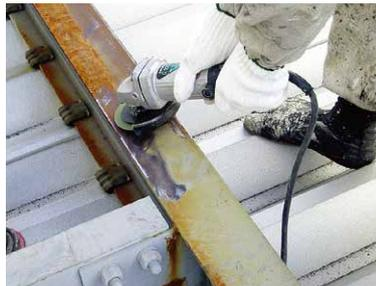
Prepare la Superficie Metálica Mediante Limpieza con Chorro de Arena (Sandblast) o con Herramientas Eléctricas y/o Mecánicas Adecuadas. Elimine Todo Tipo de Contaminación de la Superficie, como Humedad, Aceite o Grasa, Escala de Laminación, Óxido y Pinturas Viejas.
