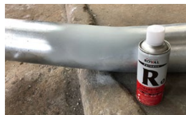
Pembaikan dengan menggunakan ROVAL
