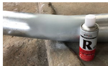
Pembaikan dengan menggunakan ROVAL
