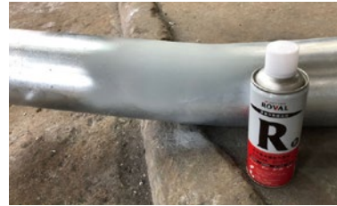
Sửa chữa bằng ROVAL
